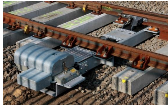
Figuur 3. Wisselsteller NSE geïnstalleerd in het spoor.
